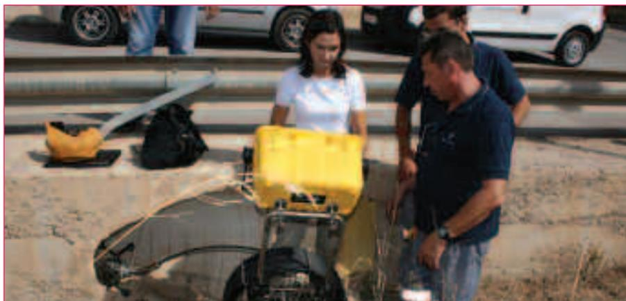
**Plan de prevención de inundaciones.** Torrent prepara su alcantarillado para evitar inundaciones. Los técnicos usan un robot provisto de cámara para controlar las posibles obstrucciones en el alcantarillado.
