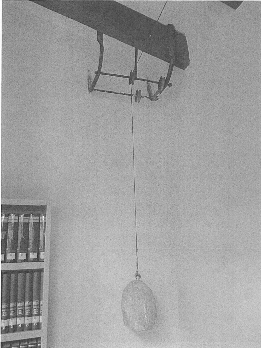
Imatge actual d'un dels contrapesos de pedra ubicat a la sala d'estudi i lectura de la planta segona de l'Antic Ajuntament, actual Casa de la Cultura, que formen part del sistema del rellotge.
