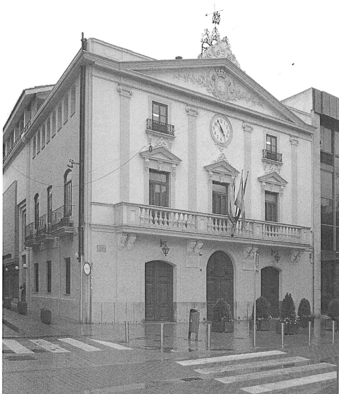
Imatge actual de la façana principal de l'Antic Ajuntament de Torrent, hui Casa de la Cultura, en la qual s'observa, en la part central superior, l'esfera del rellotge i, darrere de la coronació d'aquest alçat, l'estructura que sustenta els tres campanons.
